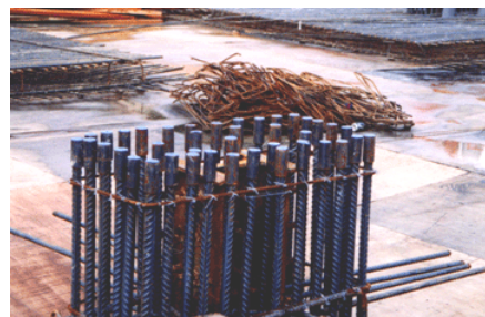
Hình 8 - Nối cốt thép bằng ống ren cho cột
