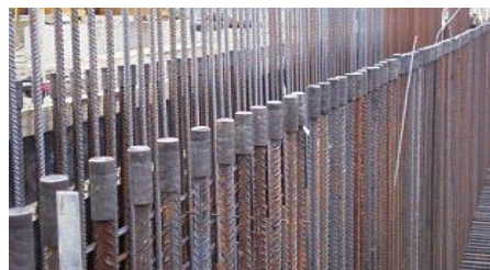
Hình 7 - Nối cốt thép bằng ống ren cho vách
