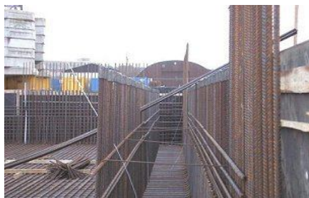
Hình 4 - Nối cốt thép bằng ống ren tầng hầm
